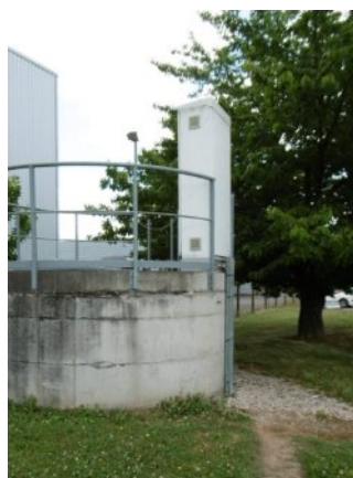
Puits de pompage
