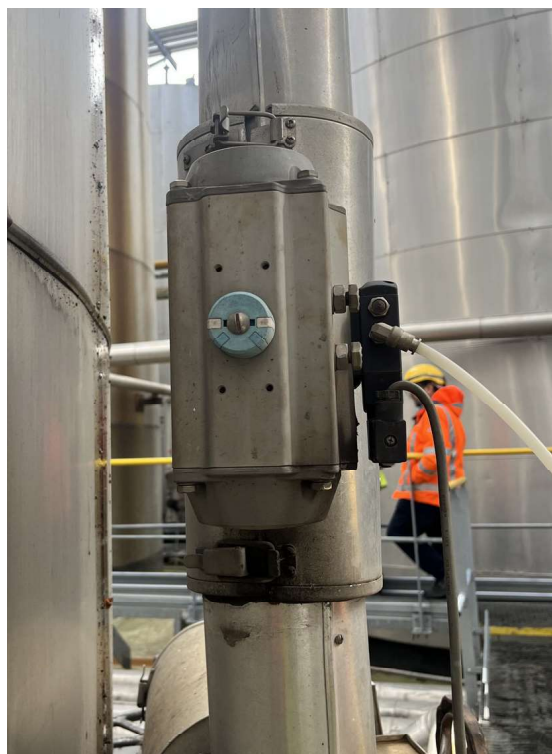
Figure 4: Vanne automatique d'approvisionnement en vapeur du bac T2615 en position fermée
