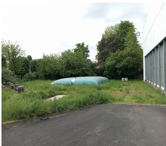
Réserve d'eau souple d'extinction incendie de 120 m 3
