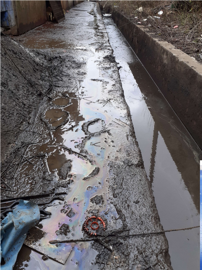
Figure 1: Caniveau souillé par des hydrocarbures
