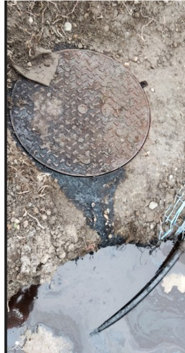
traces de débordement au niveau du regard sur une zone non étanche
