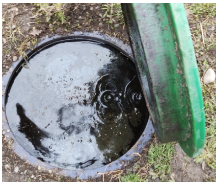
Engorgement du séparateur à hydrocarbures par des effluents souillés
