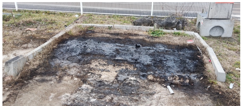
dépôt de résidus d'émulsion de bitume sur une aire non étanche
