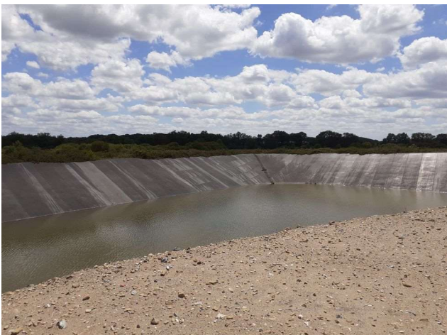
Partie de l'alvéole à combler.
