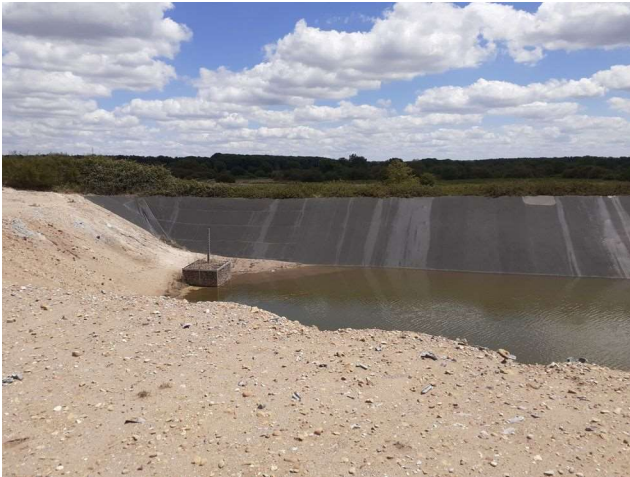
Partie de l'alvéole à combler.
