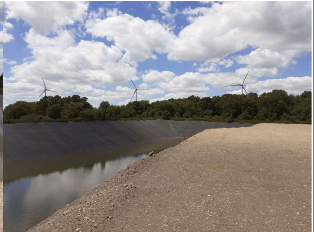
Partie de l'alvéole à combler.
