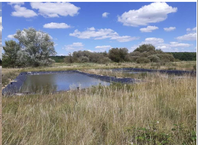
Bassins de décantation.
