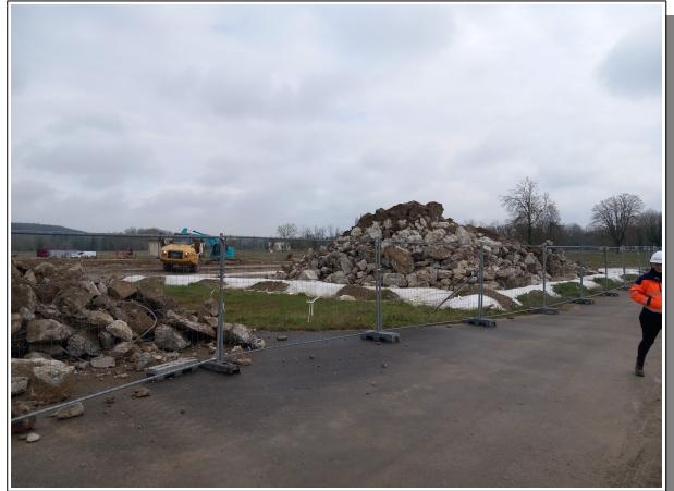
La visite du chantier depuis l'extérieur des barrières a permis de visualiser les travaux de démantèlement des dernières infrastructures, les zones de stockages des matériaux de déconstruction, l'équipement de traitement (sur rétention souple) par charbons actifs des eaux d'ennoyage sous dalles (traitement avant rejet dans la Charente). De plus, les stockages de carburant et le groupe électrogène dédié au chantier étaient associés à des dispositifs de type double enveloppe.
