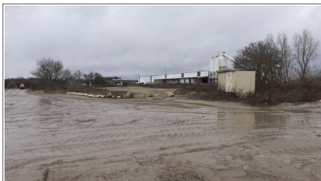
Photo 1 : absence de clôture (16/02/2022)
