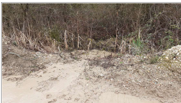
Photo 3 : rejet eaux pluviales chargées en fines direct au fossé (16/02/2022) (16/02/2022)
