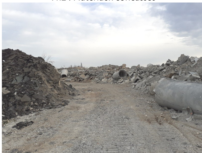
Ph4 : Déchets bétons et agrégats d'enrobés
