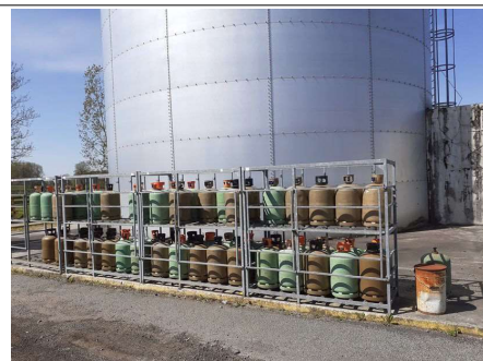
Stockage des bouteilles de gaz (alimentation des chariots) a proximité immédiate de la réserve sprinklage
