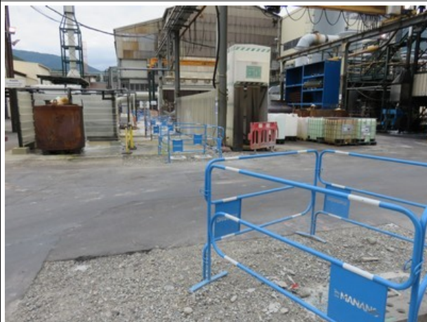
Génie civil pour l'accueil des fondations du rack Nord
