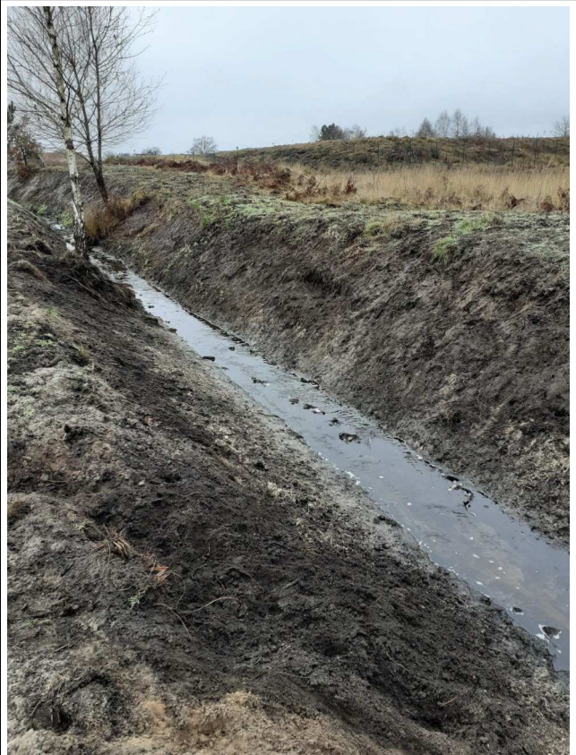
Photo 12 : fossé de collecte des eaux
