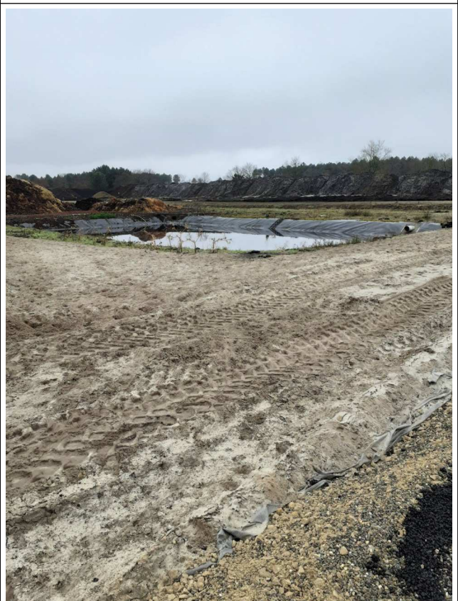
Photo 4 : bassin de collecte des effluents de la plateforme de compostage sans pompe
