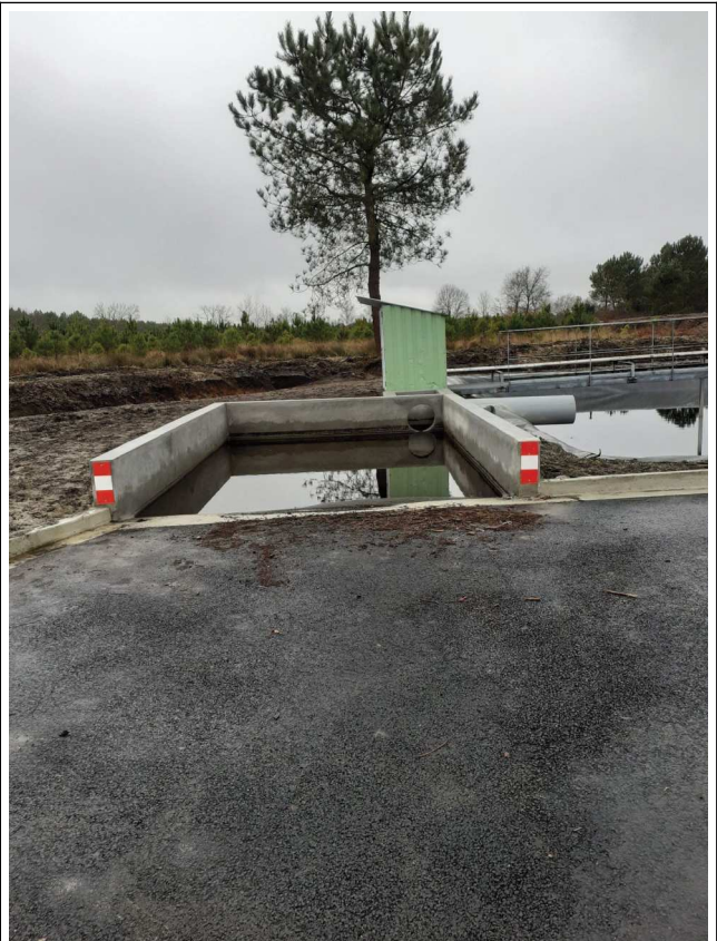
Photo 2 : bassin de collecte des effluents de la future plateforme
