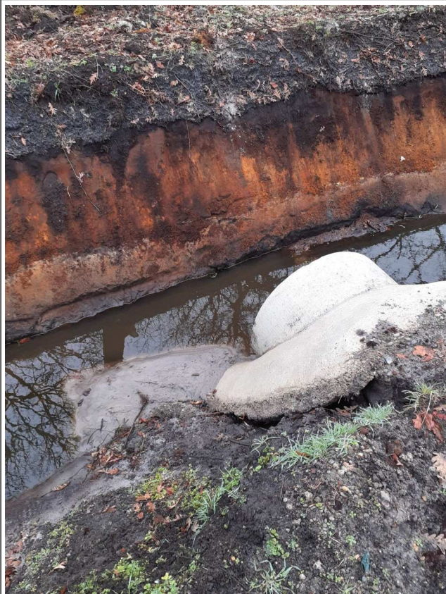
Photo 11 : point de rejet en bout de plateforme des produits finis
