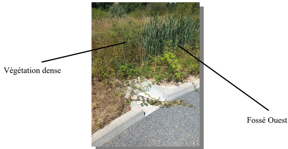
En particulier, elle ne permet plus d'accéder ni aux bouches pompier installées à proximité de l'étang servant de ressource incendie (réserve d'eau de 450 m<sup>3</sup> prescrite), ni à la vanne de confinement en aval du bassin de 400 m<sup>3</sup>.
