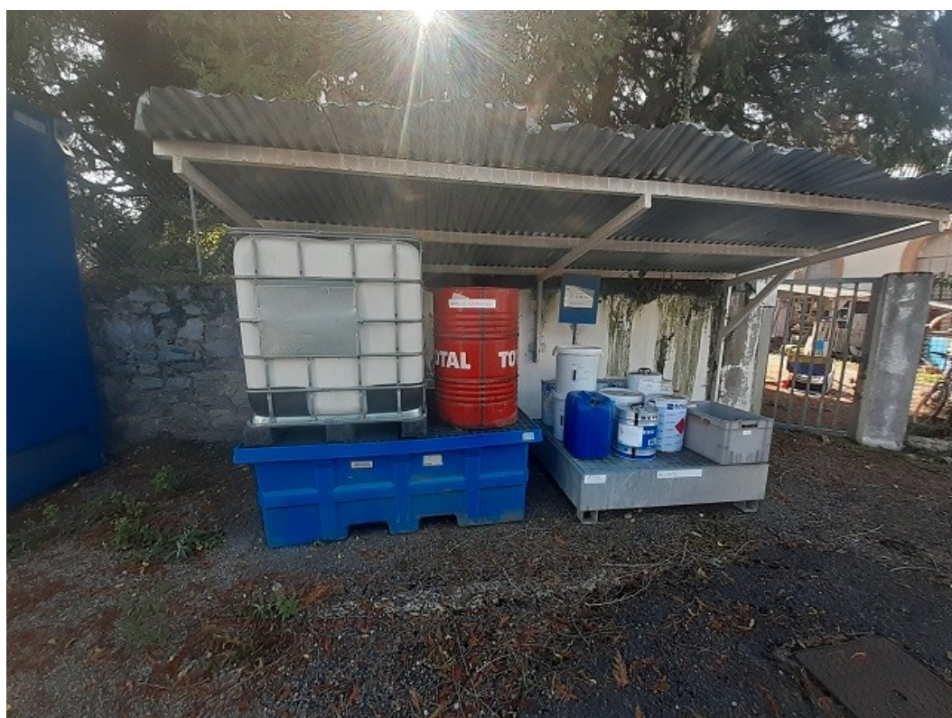
Photos n°3 : bac de rétention extérieur
