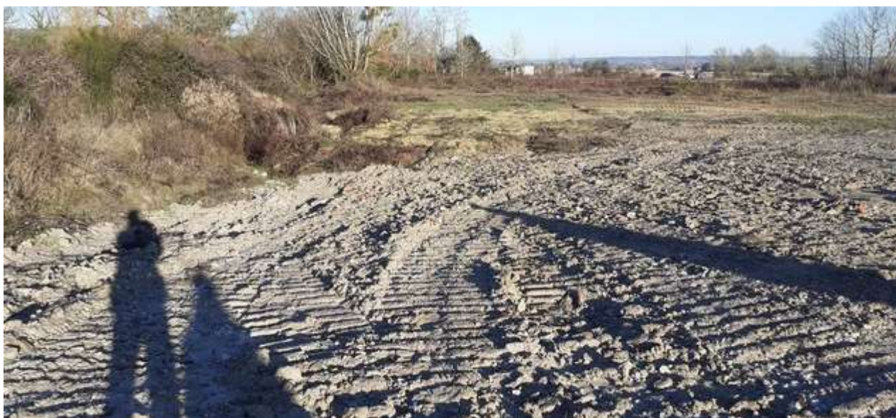
Vues de la zone remise en état par l'exploitant (déchets inertes aplanis mais non recouverts)
